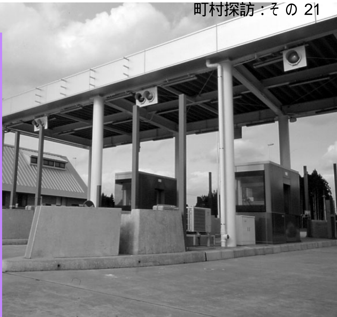
4月10日の開通を控え、整備が進められる料金所。JH仕様を簡略化し、中央のレーンを双方向にした3レーンが特徴。
