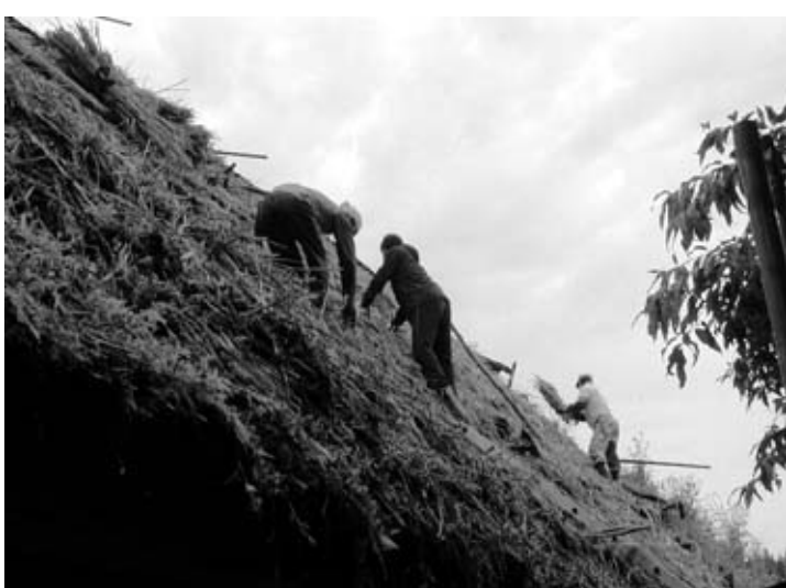
村唯一の萱葺き職人とボランティアによる修復作業
